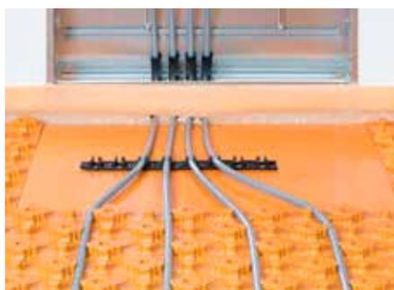
Le panneau de mise à niveau Schlüter-BEKOTEC-ENFG se monte dans la zone du collecteur afin de faciliter le montage des tubes de chauffage dans le coffret pour collecteur. Le panneau en polystyrène est fixé sous la dalle à plots à l'aide de la bande adhésive double face fournie (6 m).
