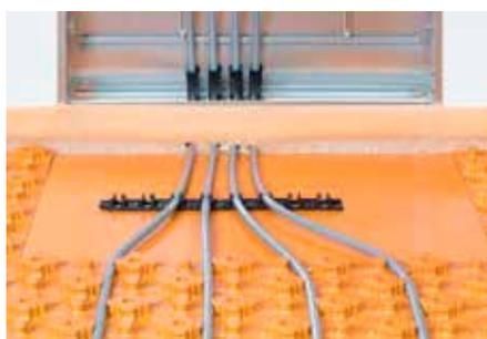
Le panneau de mise à niveau Schlüter-BEKOTEC-ENFGI avec isolation thermique et acoustique se pose dans la zone du collecteur afin de faciliter le montage des tubes de chauffage dans le coffret pour collecteur.
